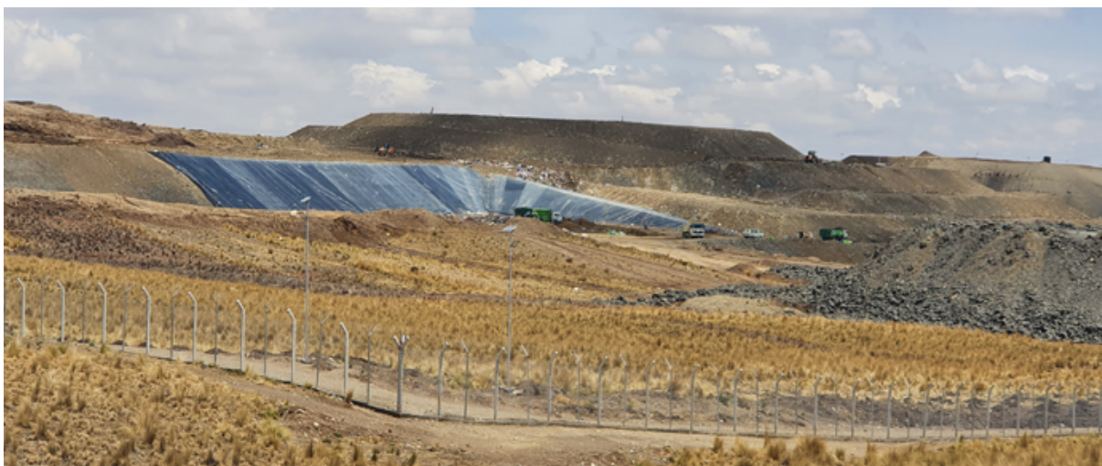
Fuente: Cerco perimetral, Relleno Sanitario "El Ingenio", Municipio de El Alto
