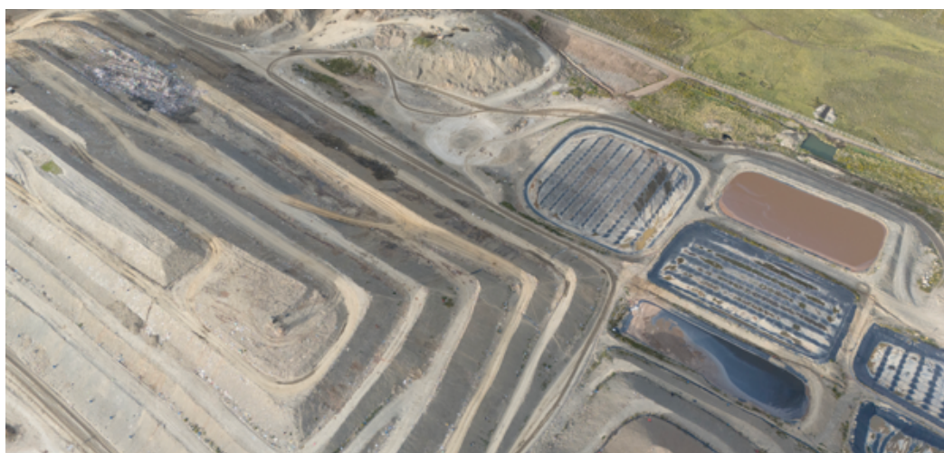
Figura 23. Sistema de almacenamiento de lixiviados
