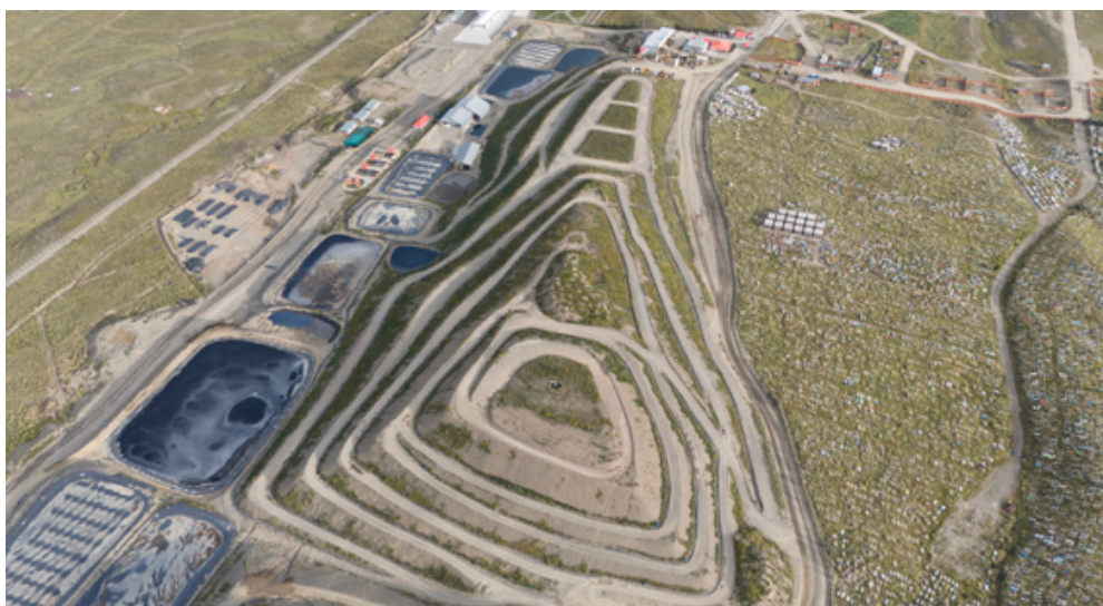
Figura 60. Cobertura Final con Carpeta Vegetal
