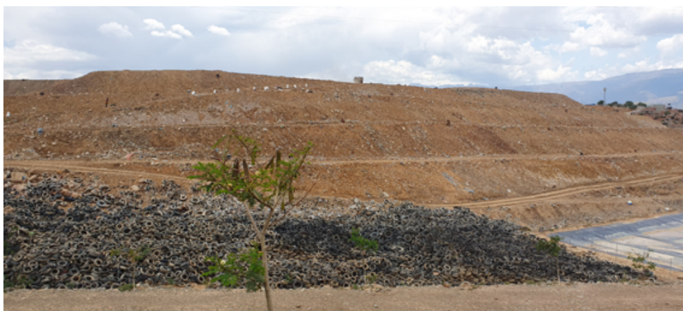
Figura 59. Cobertura Final Terrea
