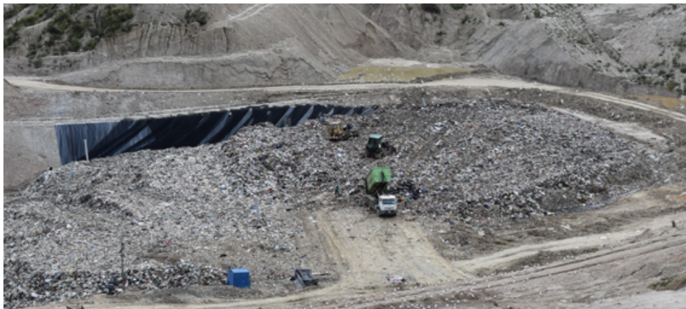
Figura 56. Compactación de Residuos.
