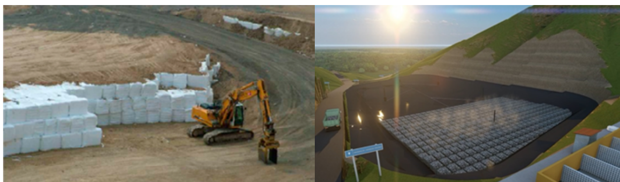
Figura 34. Relleno sanitario semi-seco
