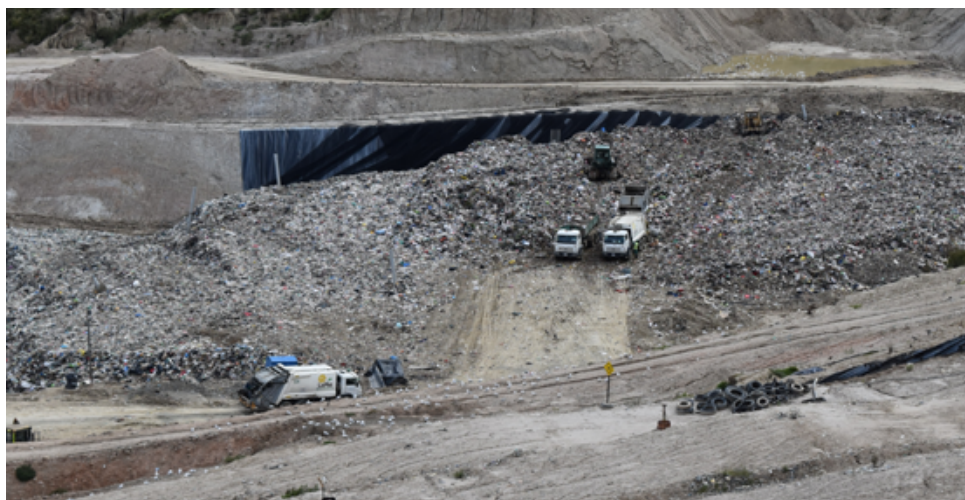
Figura 55. Distribución y conformación de residuos en celda.
